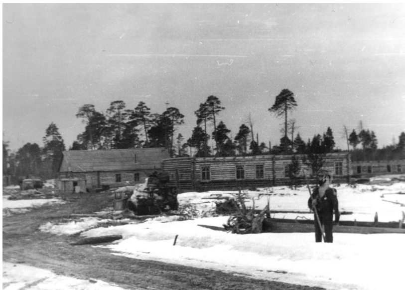
Строительство гаража в 1962 году.
