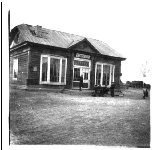
Здание сельмага (построено в 1938 г.)
