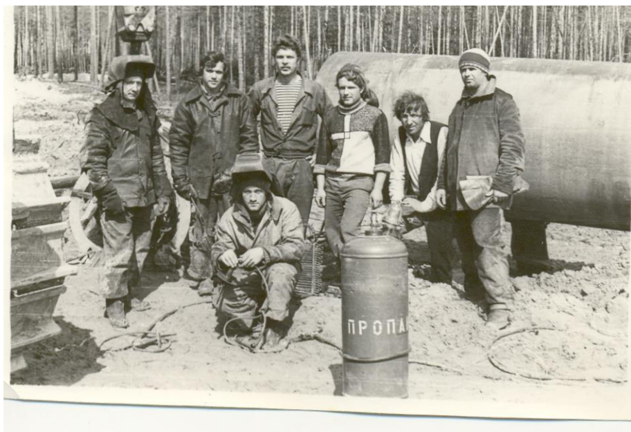
На строительстве ЛПДС «Кедровое».
