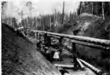
Метод для оттаивания ветками лесозащитной дороги — Катанский район Западно-Сибирского края, 1931 г.
