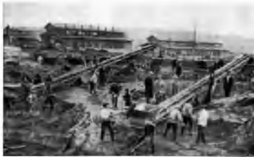
Курьинский. Начало закладки работ на доломитном месторождении, 1929 г.
