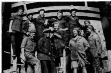
Коллектив рабочих за строительство Кузнецкого металлургического комбината.
