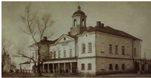
Здание гауптвахты. Нач. XX в.
