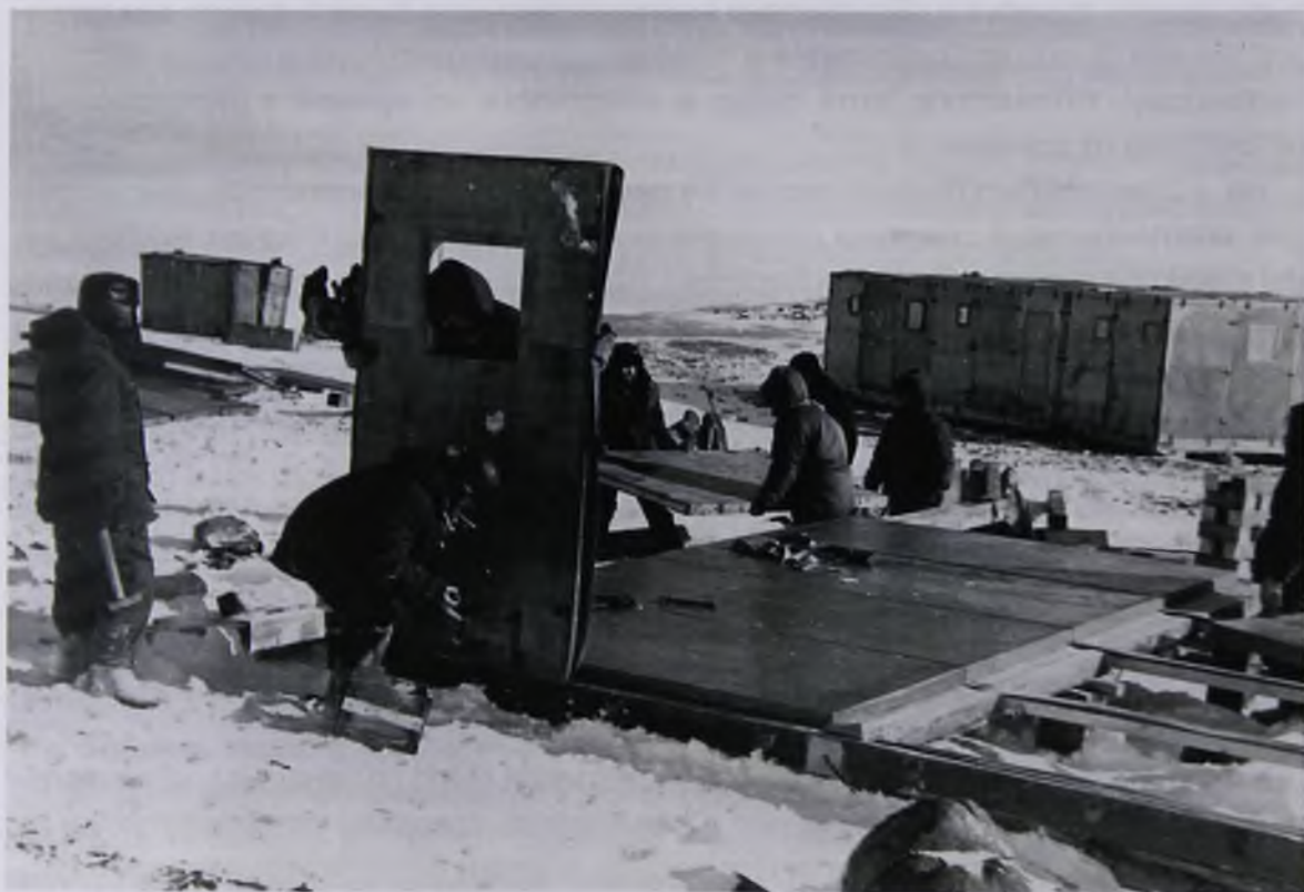
Строительство на Русской
