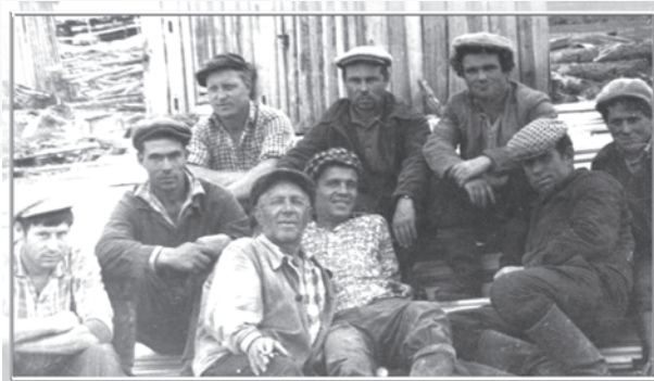
Бригада строителей И. С. Прокаева, 1965 г.
