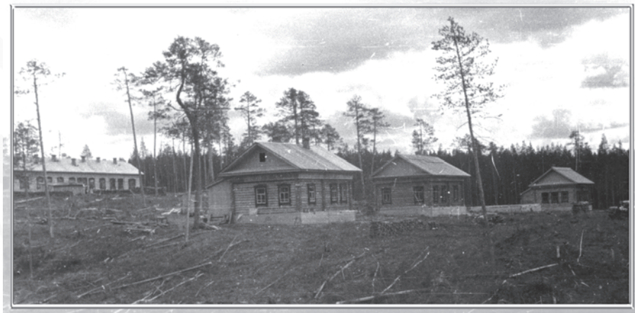
Деревня Хангокурт, строительство домов
