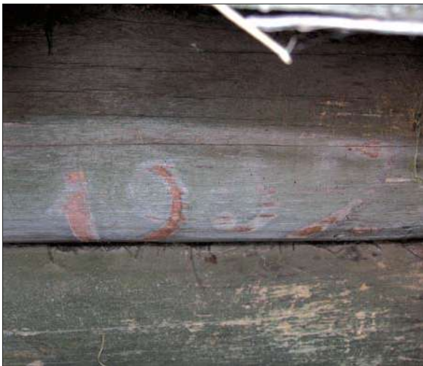
Ил. 5. Церковь во имя иконы «Всех скорбящих радость». Д. Зенково Ханты-Мансийского р-на ХМАО — Югры. Обнаруженная при ремонте обшивки цоколя северной стены надпись краской: «1909». Снято с севера. 11.08.2016. Фото: Я.А. Яковлев
