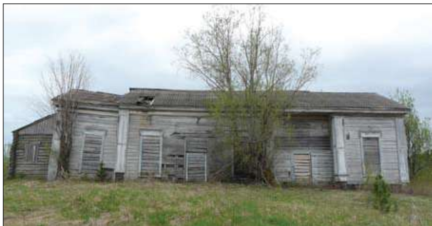
Ил. 3. Здание церкви Богоявления Господня в д. Юган Сургутского р-на. Северный фасад. Снято с севера. 05.07.2017. Фото: А.Н. Сабаров
