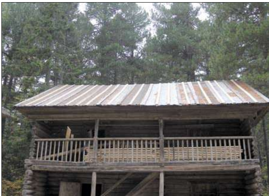
Ил. 47. Сухоруковский амбар. Отремонтированная крыша. Укреплённые перила на 2-м этаже. 20.09.2016. Фото: Я.А. Яковлев
