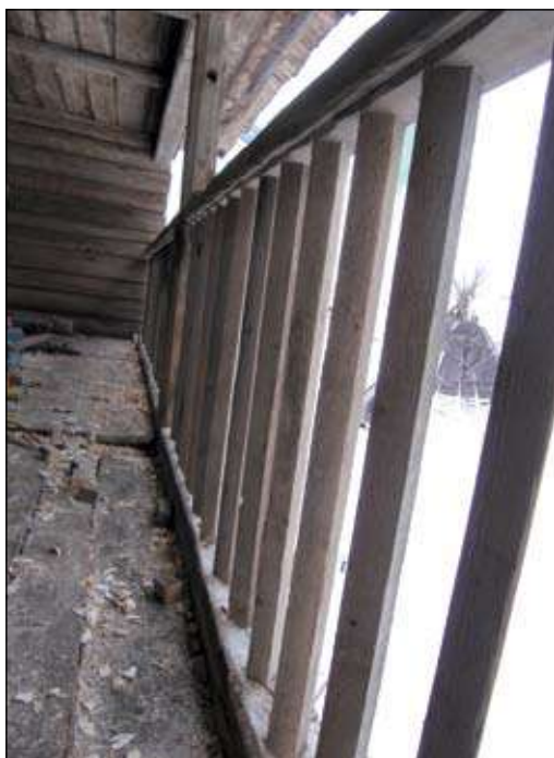
Ил. 40. Сооружение перил и балясин на галерее 2-го этажа постройки на территории музея «Торум маа» в г. Ханты-Мансийске. 30.10.2015. Фото: Я.А. Яковлев
