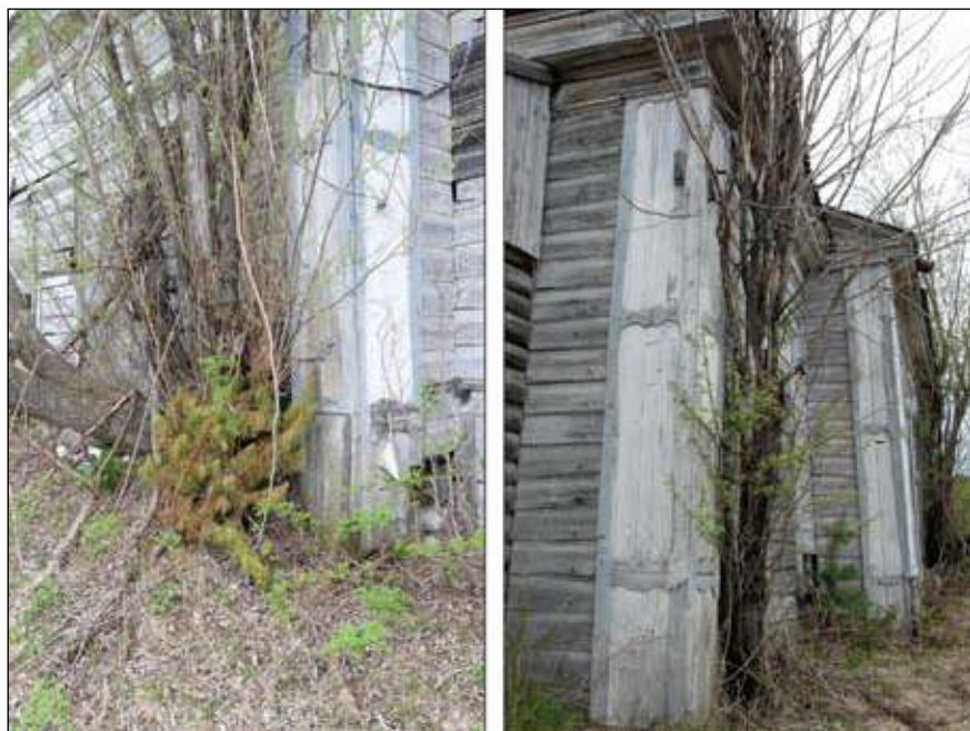
Ил. 4. Здание церкви Богоявления Господня в д. Юган Сургутского р-на. Корни деревьев, разрушающие нижние венцы сруба. 5.07.2017. Фото: А.Н. Сабаров
