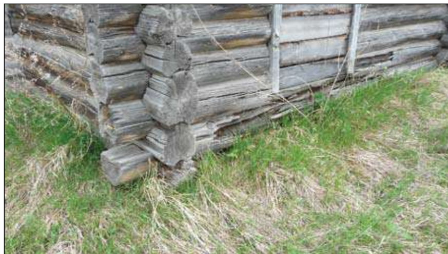
Ил. 5. Здание церкви Богоявления Господня в д. Юган Сургутского р-на. Восточный фасад. Нижние венцы деревянного прируба. Снято с востока. 05.07.2017. Фото: А.Н. Сабаров
