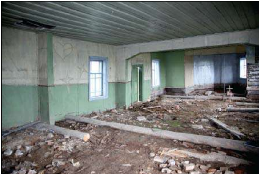
Ил. 33. Церковь во имя Нерукотворного Образа Спаса. Д. Скрипунова Ханты-Мансийского р-на ХМАО — Югры. Интерьер. Вид со стороны главного входа. 06.08.2012. Фото: Г.П. Ведмидь
