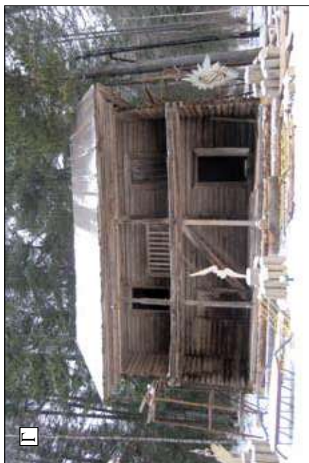
Ил. 39. Крылья постройки на территории музея «Торум маа» в г. Ханты-Мансийске. А — Стропильная система; Б — фронтон со слуховым окном; В — карниз; Г — крыша. 10.2015. Фото: Я.А. Яковлев
