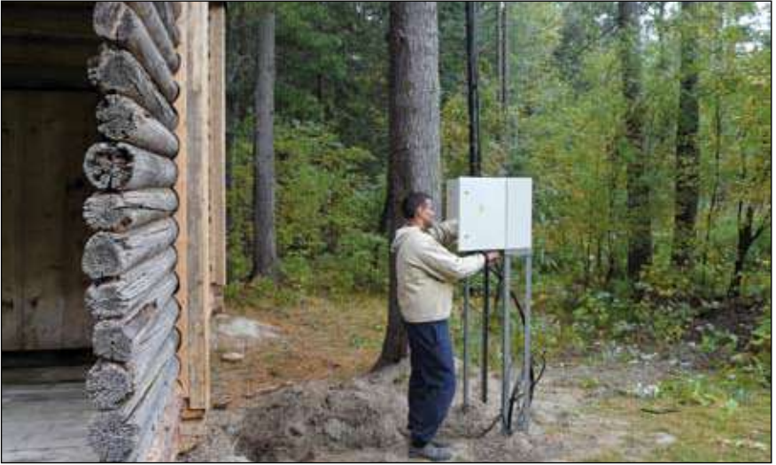
Ил. 51. Сухоруковский амбар. Монтаж электроснабжения. 06—07.09.2016. Фото: Я.А. Яковлев
