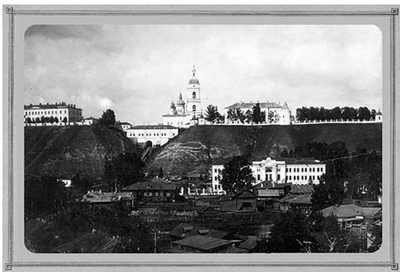
Фото 1. Вид с юга на новое здание мужской гимназии. Конец XIX в.
