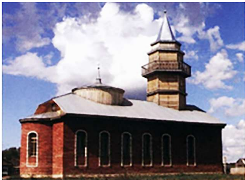
Рис. 5. Мечеть в д. Второвагай Вагайского района Тюменской области. Заложена в 1999 г., строительство завершено в 2003 г. под руководством председателя местной мусульманской общины Риската Усманова. Кирпичная кладка стен сочетается с элементами покрытых опалубкой деревянных конструкций (минарет, барабан под плоским куполом)
