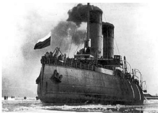
**Прим.** Построен на верфи Armstrong Whitworth (г. Ньюкасл, Англия). Спущен на воду в 1898 г. Тоннаж 8730 т. Длина 97,5 м. Ширина 21,6 м. Средняя осадка 7,3 м. Силовая установка: паровые машины 9000 л. с. Скорость 12 узлов. Автономность 4400 миль плавания. Экипаж 102 чел.
