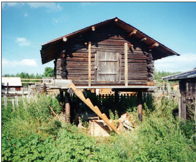
Илл. 9. Свайный амбар на металлических трубах-опорах. Северные манси. П. Хулимсунт, р. Северная Сосьва. ХМАО. 2003 г. Фото: Н.П. Вынгилева
