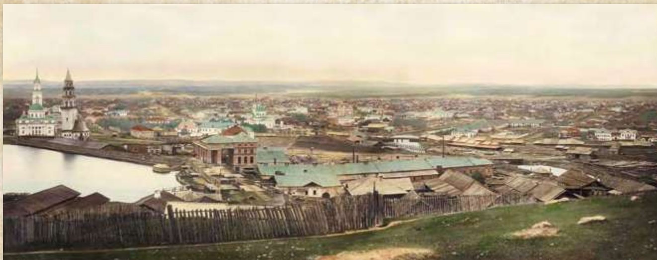
Вид Невьянского завода с горы Лебяжки.
