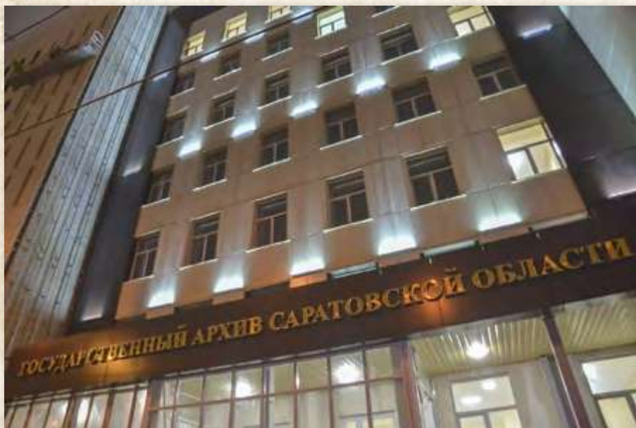
Новое здание для ГАСО
