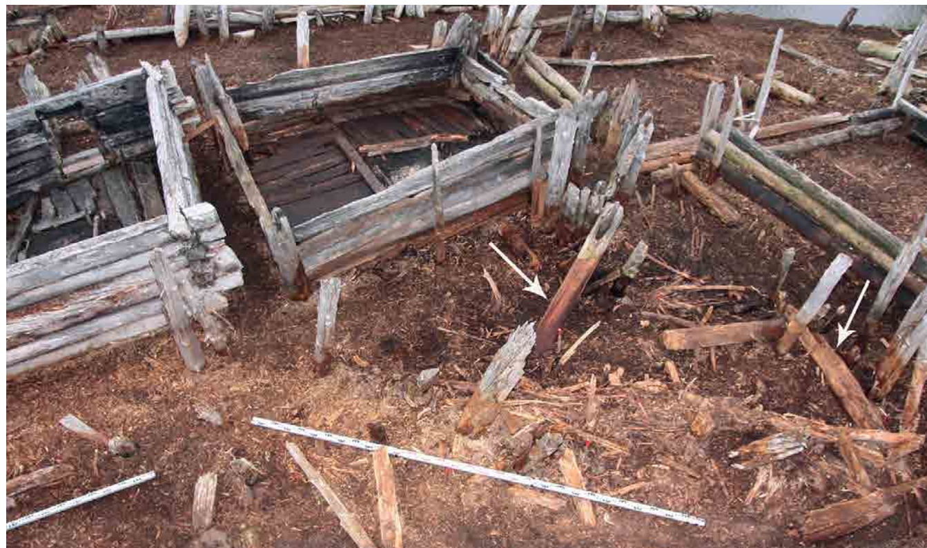
Рис. 6. Обойма, соединяющая между собой две противоположные стороны опалубки
