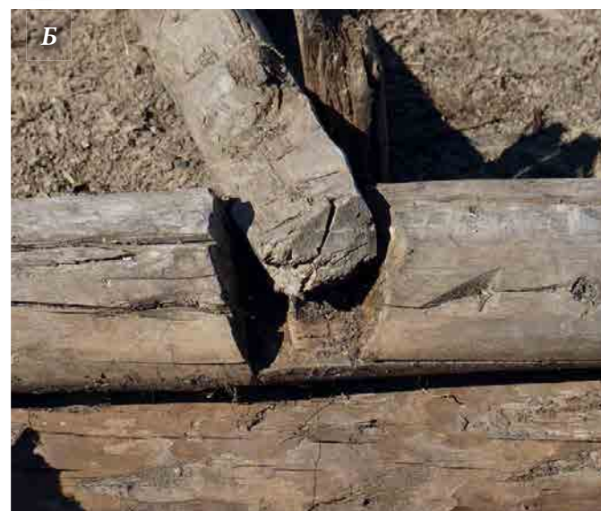
Рис. 17. Постройка 22. Срубная постройка в технике «в обло» с остатком и с нарами у юго-западной стены. А – общий вид. Б – паз, вырубленный в стене постройки для фиксации конца лаги, на которую укладывался настил нар
