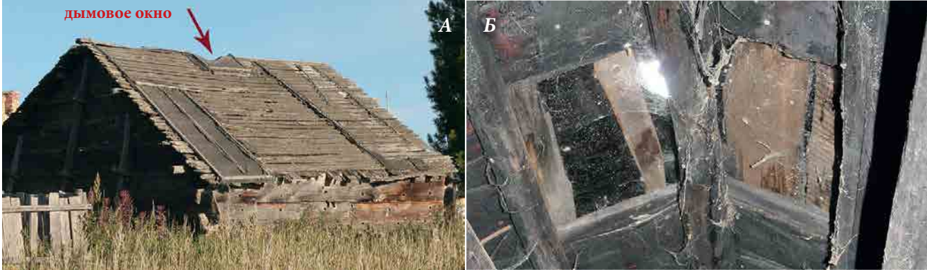
Рис. 14. Священный дом Тырлина в поселке Хошгорт. А) В верхней части кровли небольшое отверстие для дымоудаления (дымовое окно). Б) Вид отверстия для дымоудаления внутри постройки
