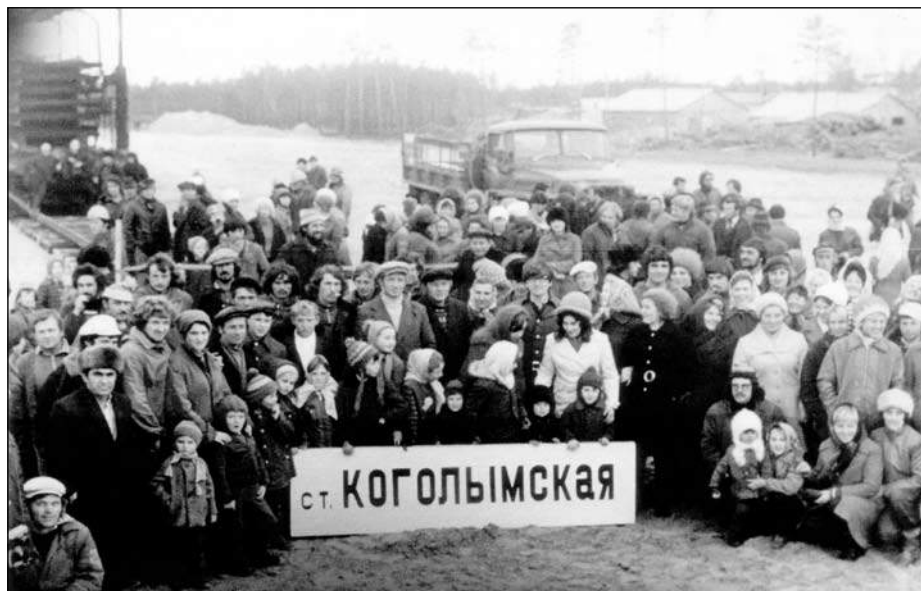
Митинг, посвящённый укладке последнего звена, на станции «Когалымская». 15 сентября 1977 г. Фото: В.Н. Мурзаков. Из фондов Музейно-выставочного центра (г. Когалым)
