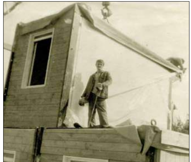
С. Угут. Строительство общежития на ул. Молодёжной. Из фондов Угутского краеведческого музея
