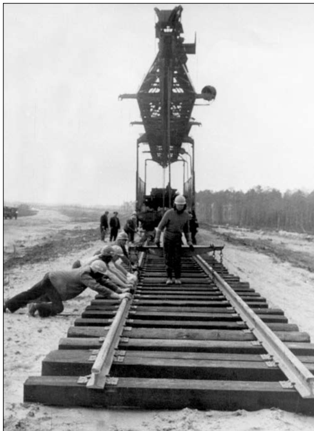
Строительство железной дороги «Сургут – Уренгой». Укладка полотна. 1977 г. Фото: В.В. Тучнолов. Из фондов Сургутского краеведческого музея
