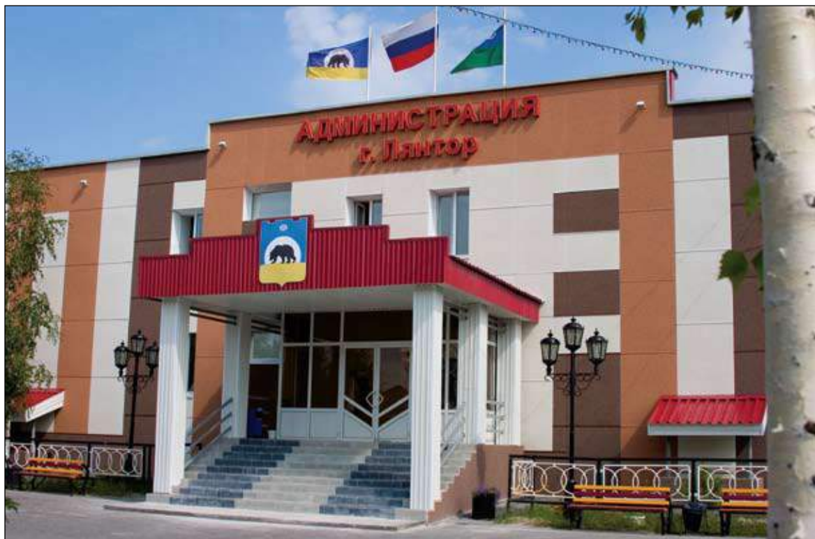
Г. Лянтор. Здание городской администрации. Фото: Э. Асаев. Из фондов Лянторского хантыйского этнографического музея
