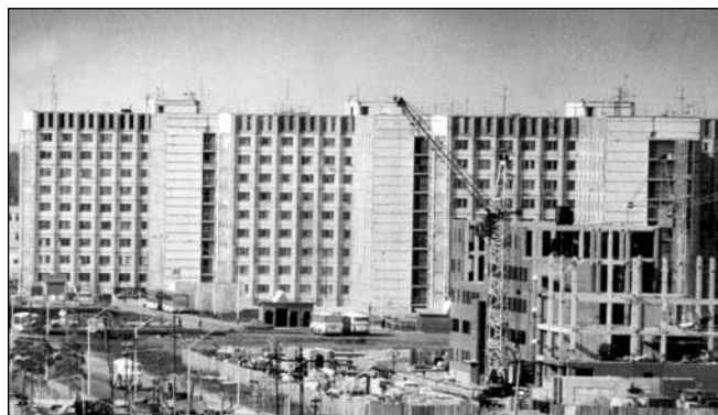
Г. Когалым. Строительство здания холдинга «ЛУКОЙЛ – Западная Сибирь». 1996 г. Фото: Ю.Н. Пучков. Из фондов Музейно-выставочного центра (г. Когалым)
