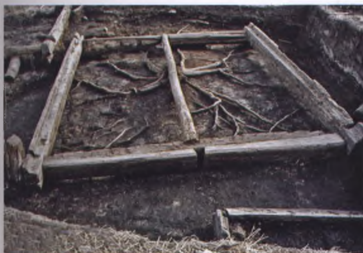
Рис. 26. Постройка № 13. Общий вид. В левом верхнем углу — угол сней постройки № 2 не перекрывает сруб постройки № 13. Участки Г-3/2-5. Вид с северо-запада
