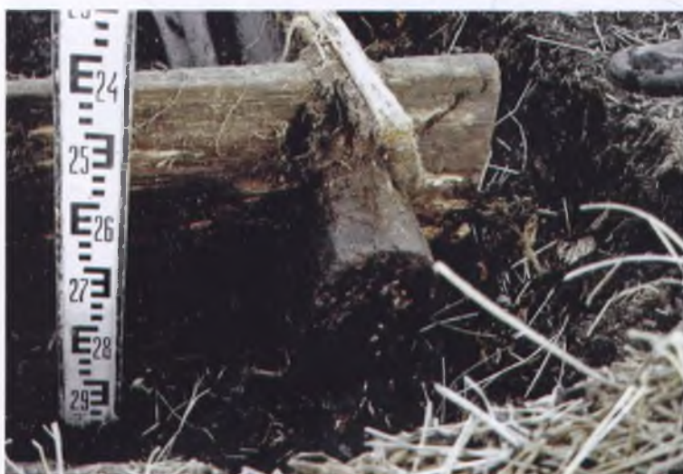
Рис. 29. Постройка № 13. Фрагмент юго-западного фасада. Бревна окладного венца и доски стен срублены в обло. Участок З/2. Вид с запада
