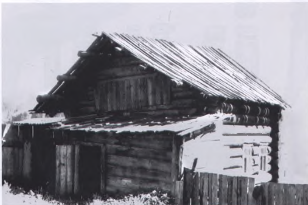
Рис. 82. Курная изба с сеними. Общий вид. Изба клетью без подклета и дымохода; крыша — самцово-слеговой конструкции; окна — косячатые (по: Бломквист Е. Э., 1956. – Ил. 78)
