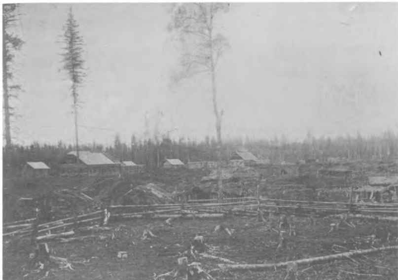
Строительство поселка на раскорчеванной гари
