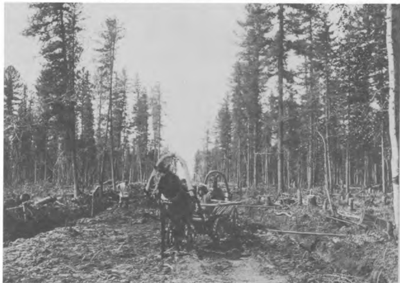
Строительство тракта Богородское-Бакчар
