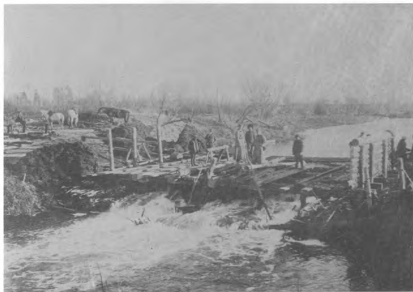
Строительство плотины на р. Емельджа
