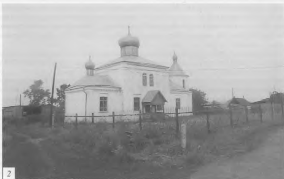
Пантелеймоновская церковь в с. Беково: 1 – до начала восстановительных работ, 1987 г., 2 – в процессе восстановления, 1999 г. Фото Д.А. Функа
