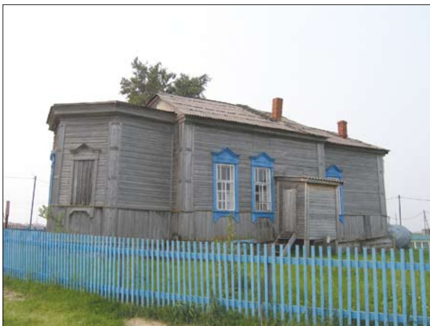
Ил. 13. Церковь во имя иконы «Всех скорбящих радость». Д. Зенково Ханты-Мансийского р-на ХМАО — Югры. Общий вид. Северный и восточный фасады. Снято с северо-востока. 18.07.2016. Фото: Я.А. Яковлев
