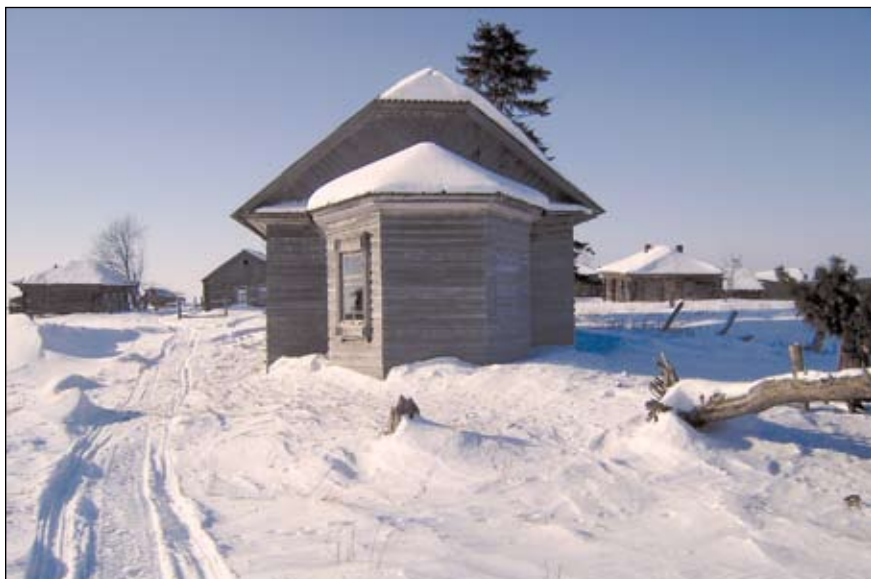
Ил. 30. Церковь во имя Нерукотворного Образа Спаса. Д. Скрипунова Ханты-Мансийского р-на ХМАО — Югры. Восточный фасад. Снято с востока. 2010 г. Фото: Н.Ю. Мухина
