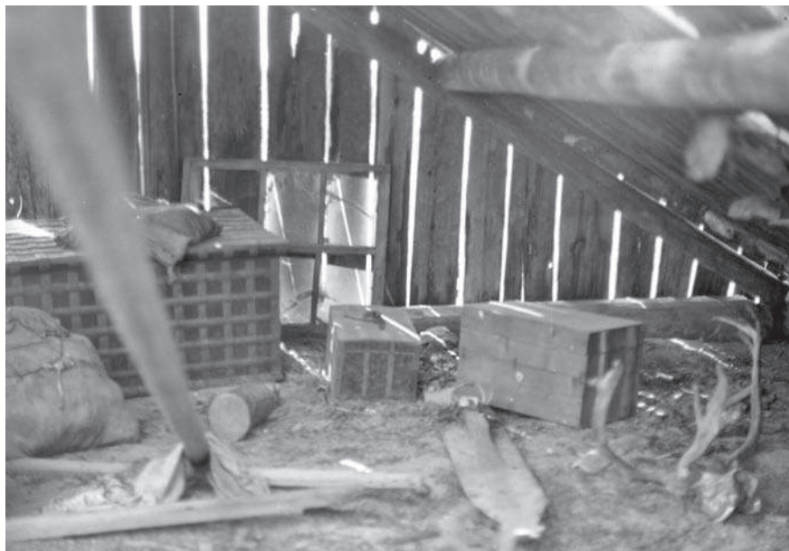
Рис. 124. Чердак дома В.Г. Овезова в Хурумпауле.
