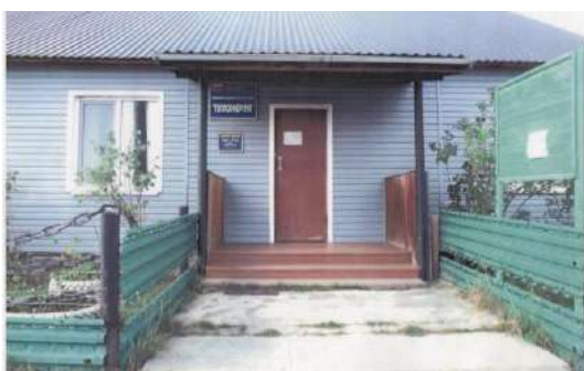
2010 г. Контора ОАО «Теплоэнергия».
