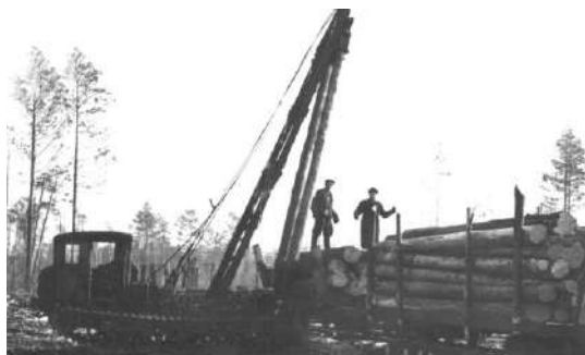
1963 год. Погрузка леса тракторкраном на подвижной состав УЖД. Бригада Самохвалова Федора Прокопьевича.
